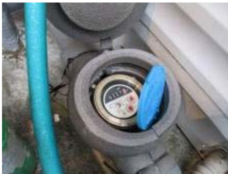
水量メーター設置
